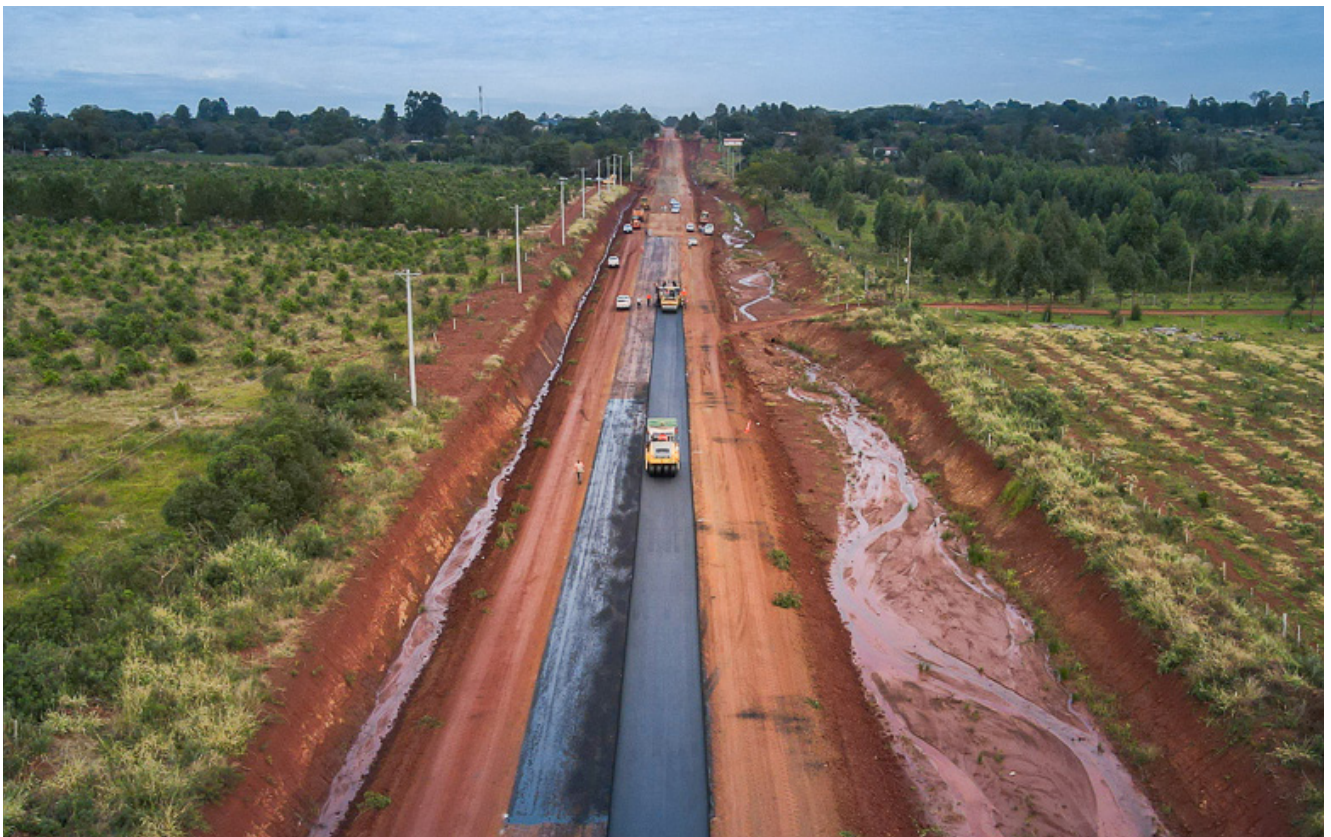
La pavimentación del último tramo de la RP 2 vinculará de forma definitiva, ágil y segura a la RP 94 de Corrientes con la Ruta Costera. Agilizando el tránsito y la logística de toda la zona del Alto Uruguay
