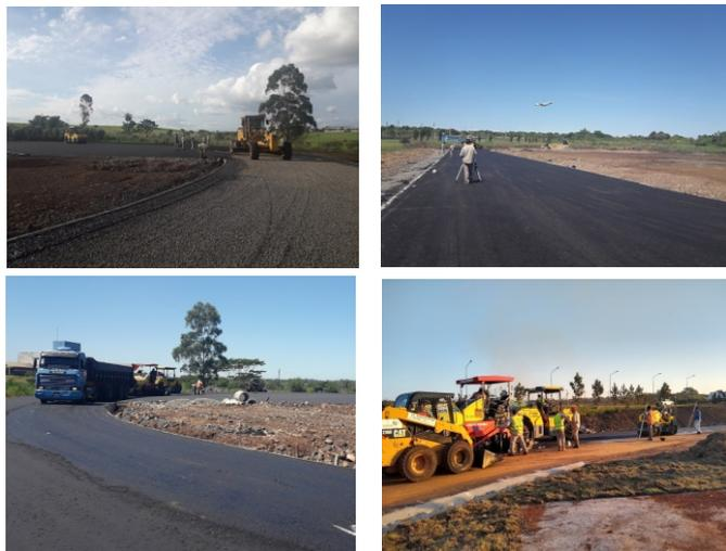
La obra comenzó con movimiento de suelo y despeje del espacio, encontrándose los técnicos con terreno arcilloso y permisible a inundaciones. Por lo que se realizó drenajes y desagües para desviar las corrientes de agua. Esta primera etapa se realizó para detectar la condición en que estaba la zona y el relevamiento previo para hacer el proyecto definitivo de la obra.
