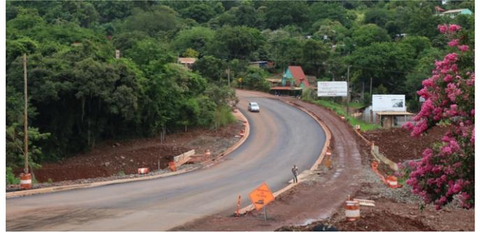
la DPV tuvo a su cargo la construcción del puente tipo alcantarilla cajón doble y el tramo carretero que incluyó: cordón cuneta, desagües, veredas, banquetas parquizadas y calzada pavimentada. El nexo vial tiene gran circulación, ya que une al casco céntrico con los barrios Cien hectáreas, Villa Stemberg, San Miguel, 180 Viviendas, Villa Londín, Villa Lindstrom; como así también con las localidades de General Alvear y Colonia Alberdi.
