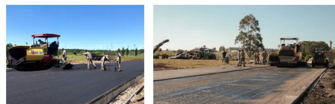
Posterior a esto se realizó el relleno con material compactado para constitución de la base. Se ha colocado una capa de asfalto de nivelación con características técnicas muy específicas para contar con el aval de competencias internacionales. La pista tiene medidas determinadas de nivelación. Finalizada esta etapa, vendrá la colocación del material sintético que se realizará in situ, con una composición tipo sándwich.
