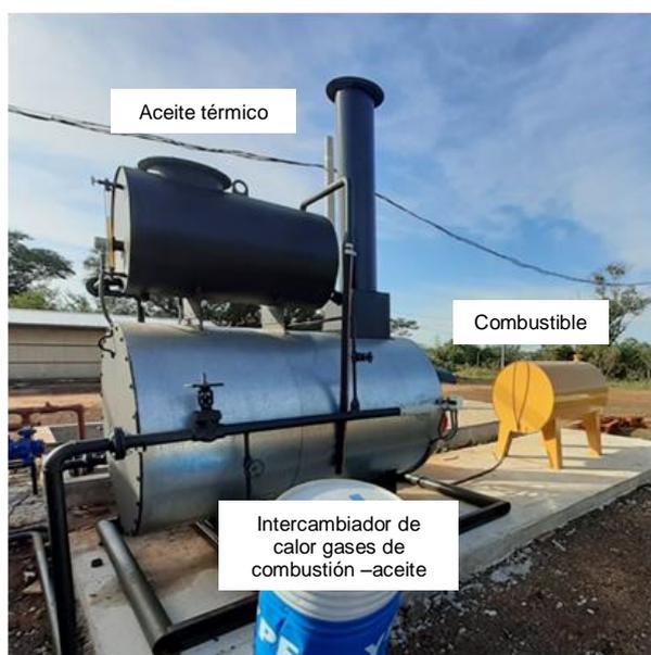
**Figura 5. Almacenamiento de combustible y calentador del aceite térmico.**
